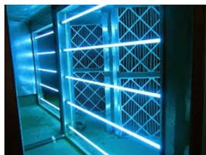
Criteria di dimensionamento: I produttori di lampade UV-C pubblicano i dati dei microwatts irradiati in funzione della potenza in W della lampada ( $\mu\text{W}/\text{W}$ ), valori questi misurati di norma alla distanza di 1 m dalla superficie della lampada. I livelli consigliati da ASHRAE, di microwatt per centimetro quadrato,
